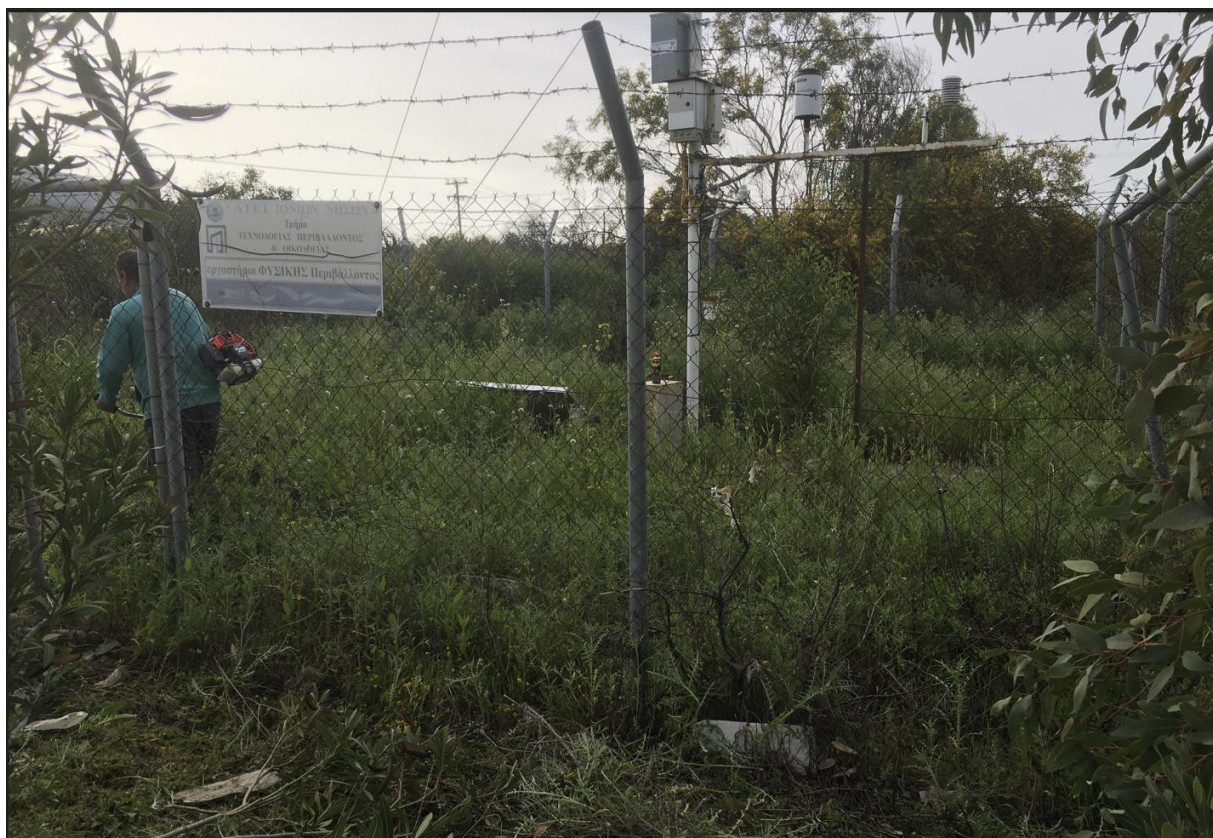
Εικόνα 2.2-3: Απο τις τεχνικές εργασίες στον σταθμό ΖΚΤ-2 στις 2/4/2021.
